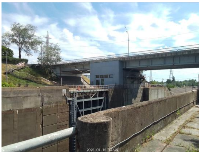
Рис. 1. Загальний вигляд моста через шлюз зі сторони верхнього б'єфу
