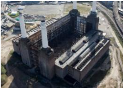
Рис. 1. Електростанція Батерсі до відновлення
