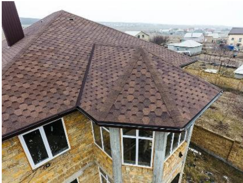
Рис. 1. Покрівля з бітумної черепиці
