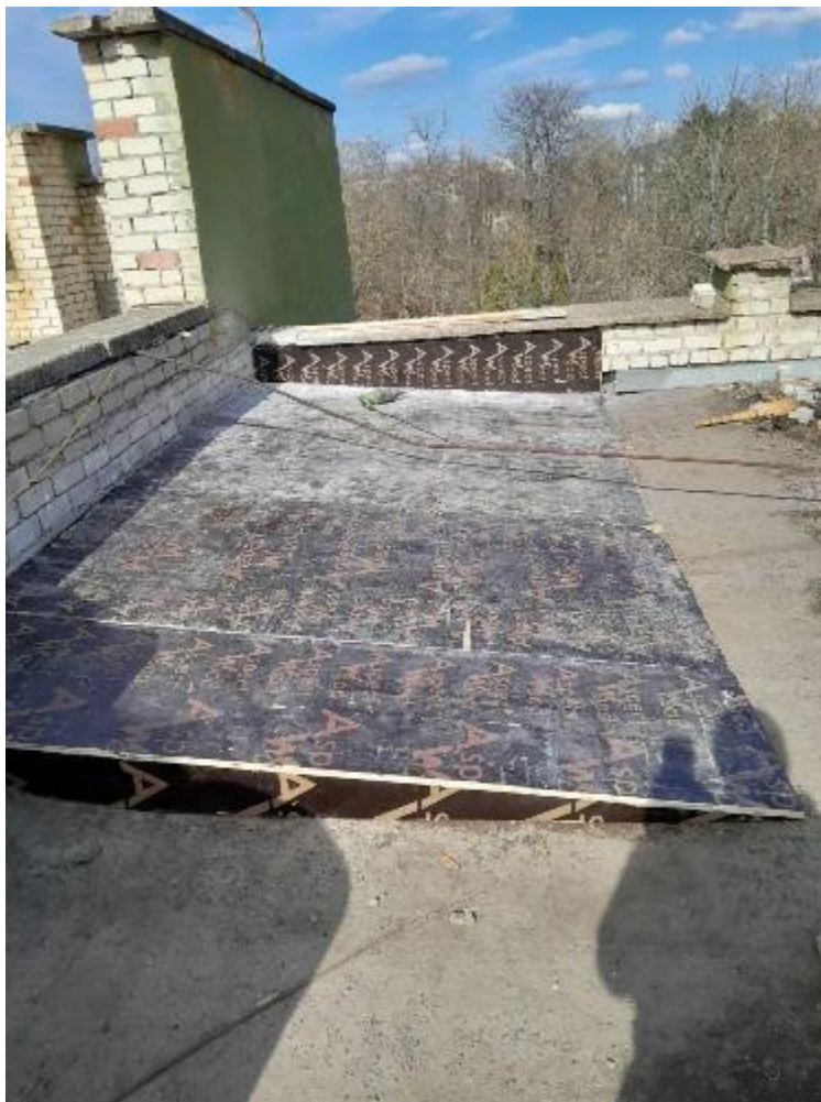
Рис. 2. Влаштування тимчасового водовідведення в місці пошкодження артобстрілом покриття
