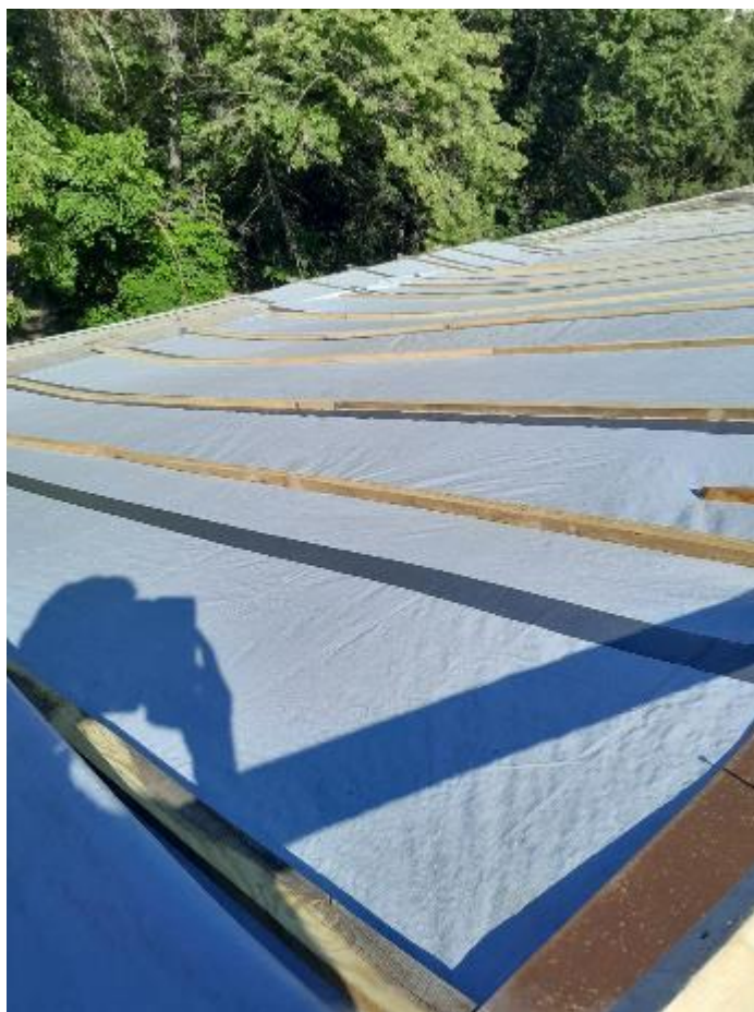
Рис. 3. Тимчасове водовідведення, гідроізоляція армованим полотном
