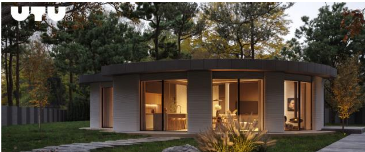
Рис. 1. Житловий будинок, побудований із використанням технології 3D друку у м. Ірпені (фото із сайту ТОВ “3D TECHNOLOGY UTU”)
