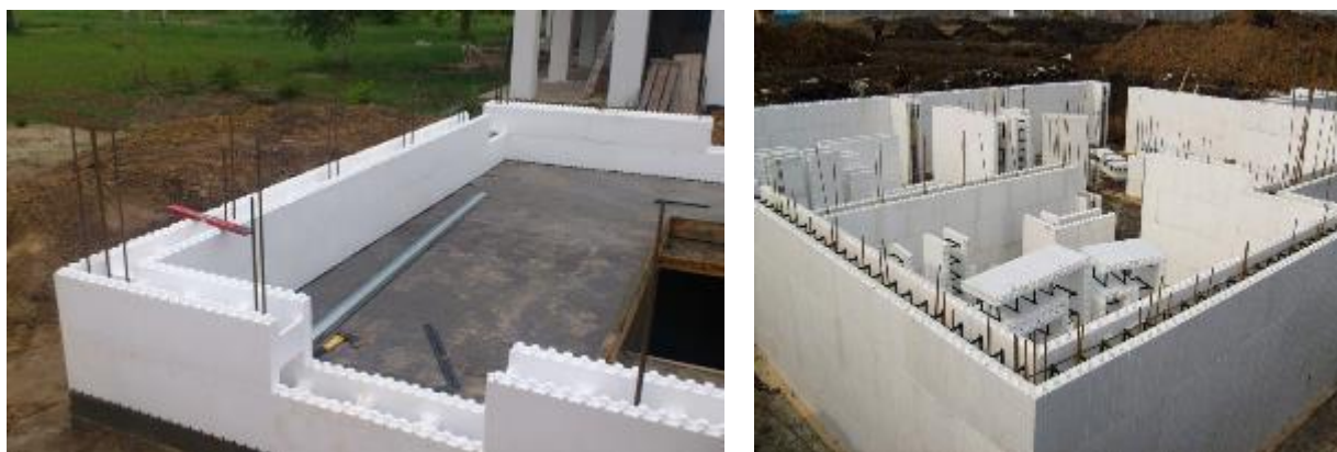
Рис. 1. Застосування незнімної опалубки при зведенні енергоефективного будинку
