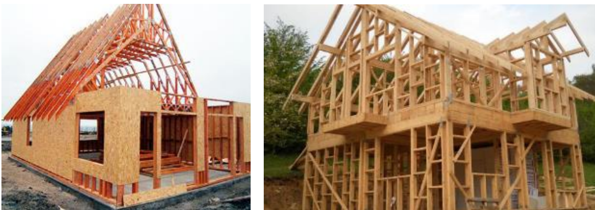
Рис. 1. Конструкція каркасних будинків з деревини
