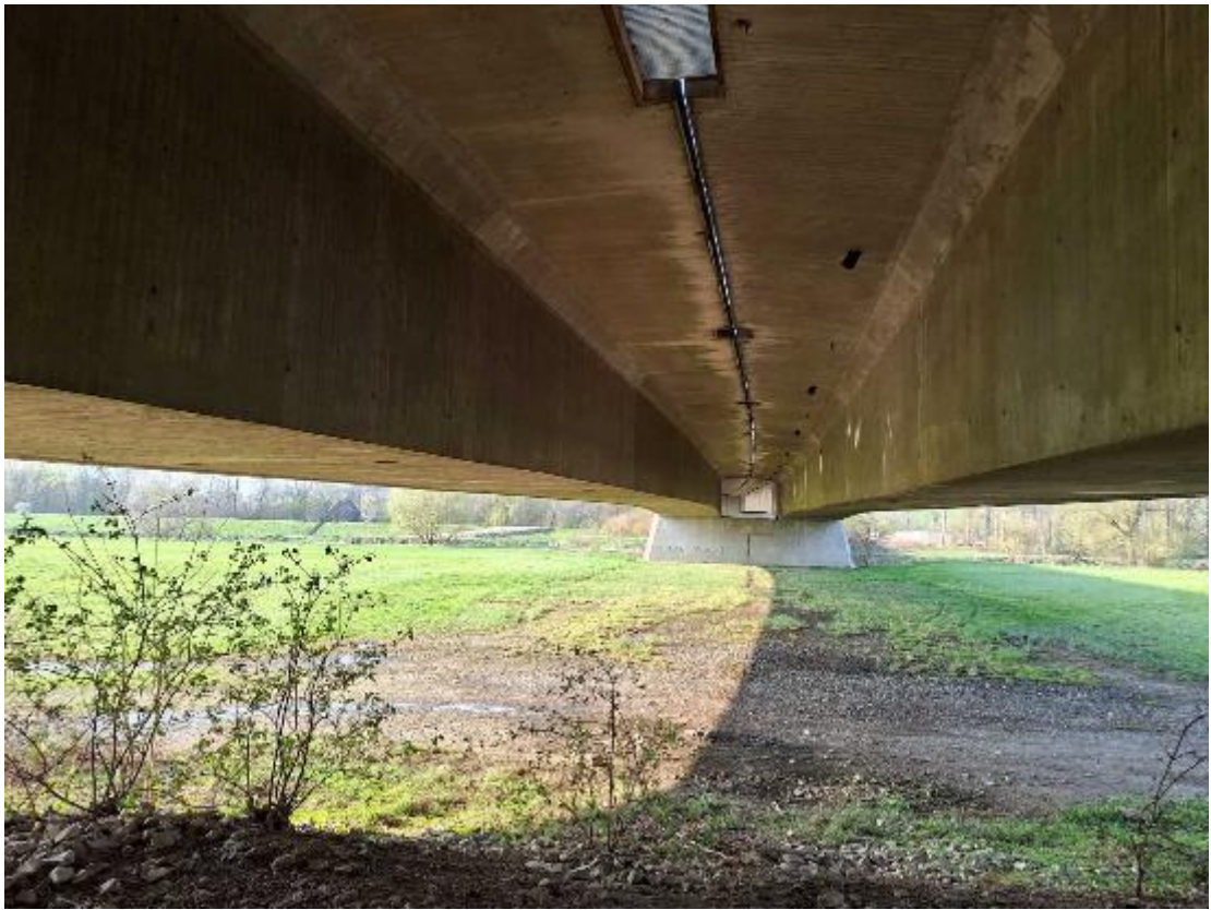
Рис. 2. Вид знизу прогонової будови моста
