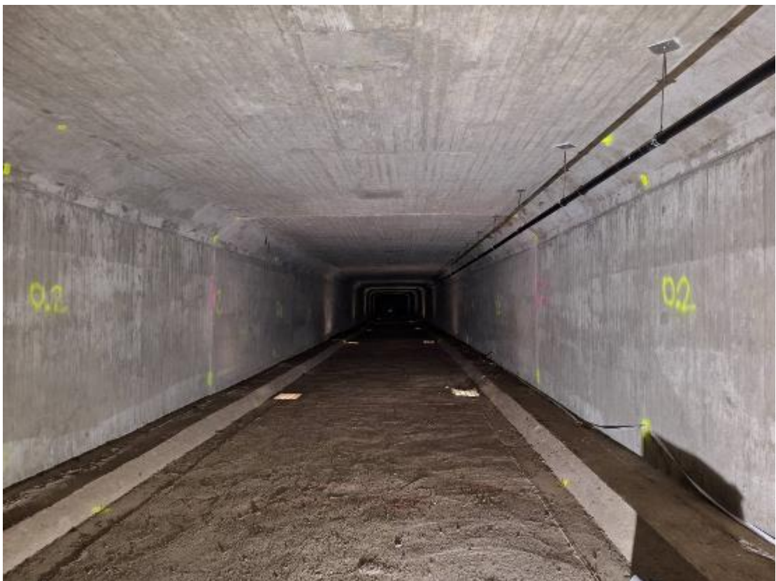
Рис. 3. Вигляд всередині коробчастої балки
