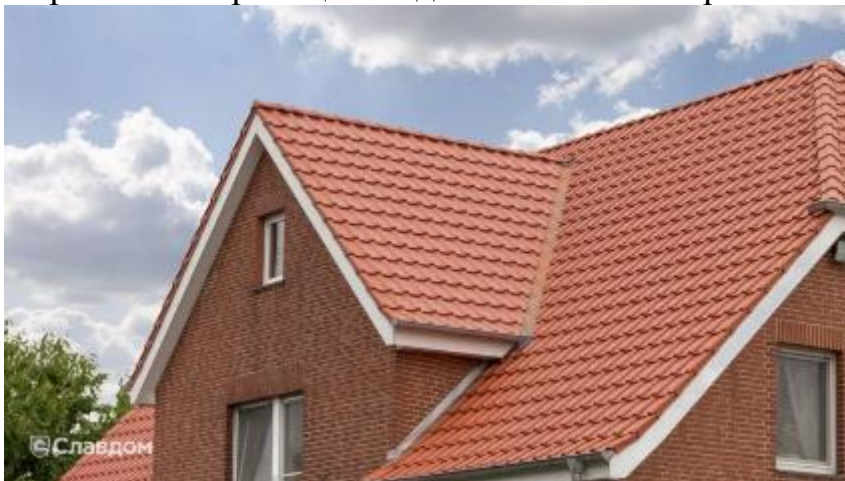
Рис.2. Покриття даху з керамічної черепиці
