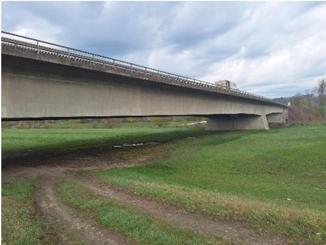
Рис. 1. Загальний вигляд залізобетонного моста
