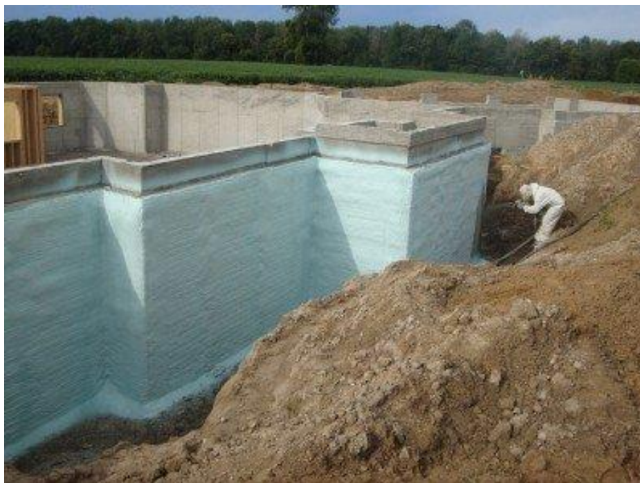
Рисунок 4 - Утеплення фундаменту пінополіуретаном
