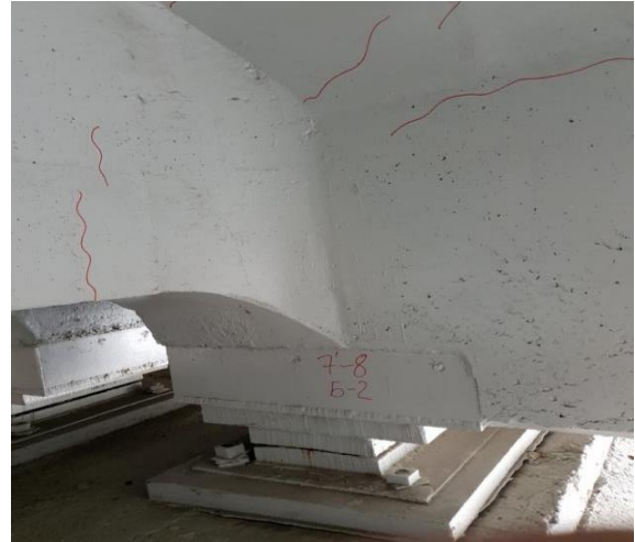
Рисунок 7 - Характерні тріщини з шириною розкриття 0,1 – 0,3 мм у діафрагмах, ребрах і полицях балок
