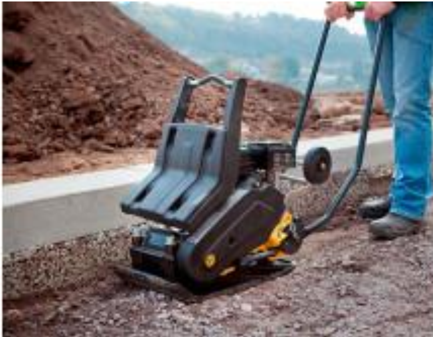
Рисунок 1 - Ущільнення ґрунтів за допомогою вібротрамбовки
