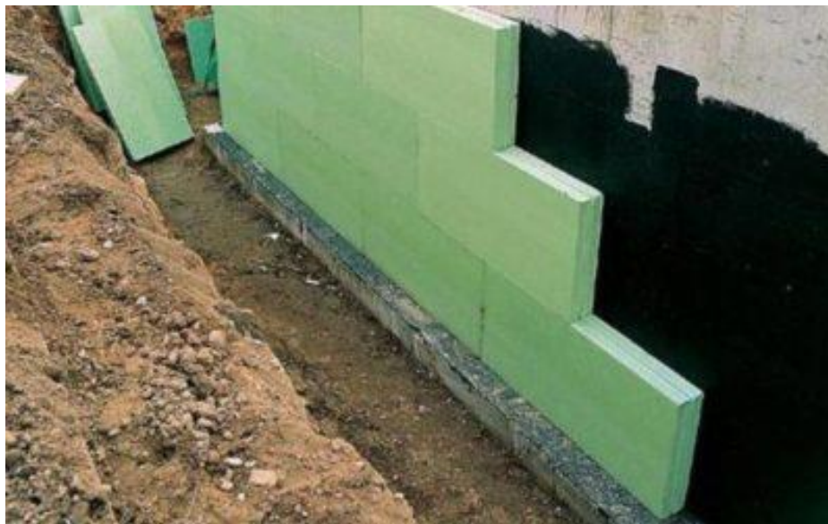
Рисунок 3 - Утеплення фундаменту екструдованим пінополістиролом
