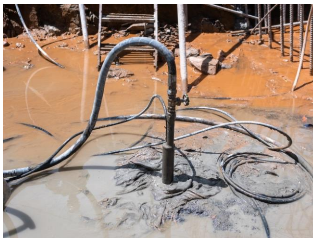
Рисунок 3 - Бітумізація ґрунту
