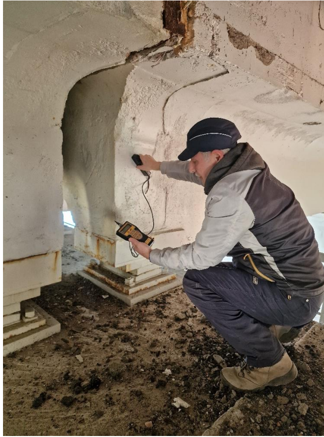
Рисунок 3 – Визначення міцності бетону ребра балки
