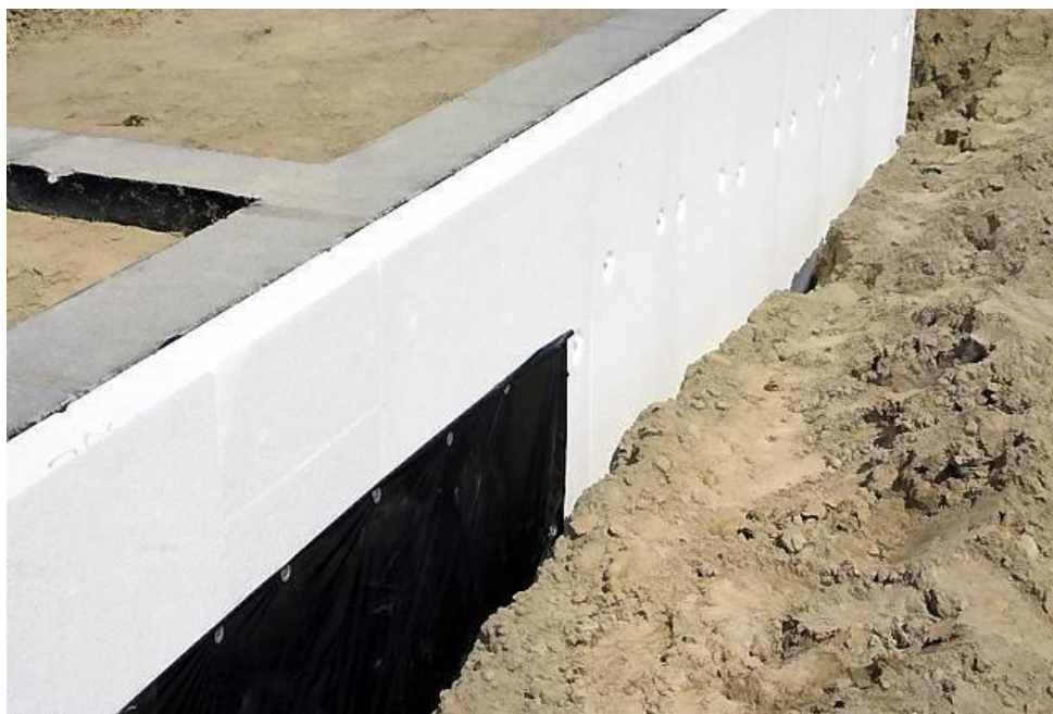
Рисунок 2 - Утеплення фундаменту пінопластом
