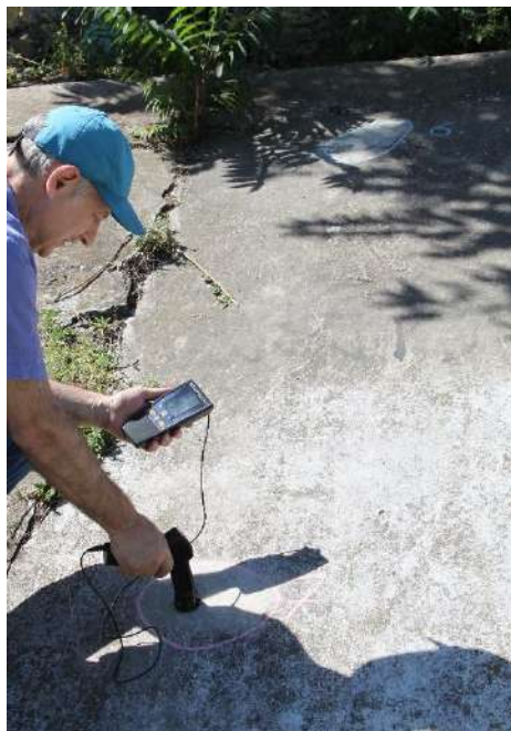
Рис.1. Оцінка міцності бетону збірних залізобетонних плит чаші «Лебедине озеро»
