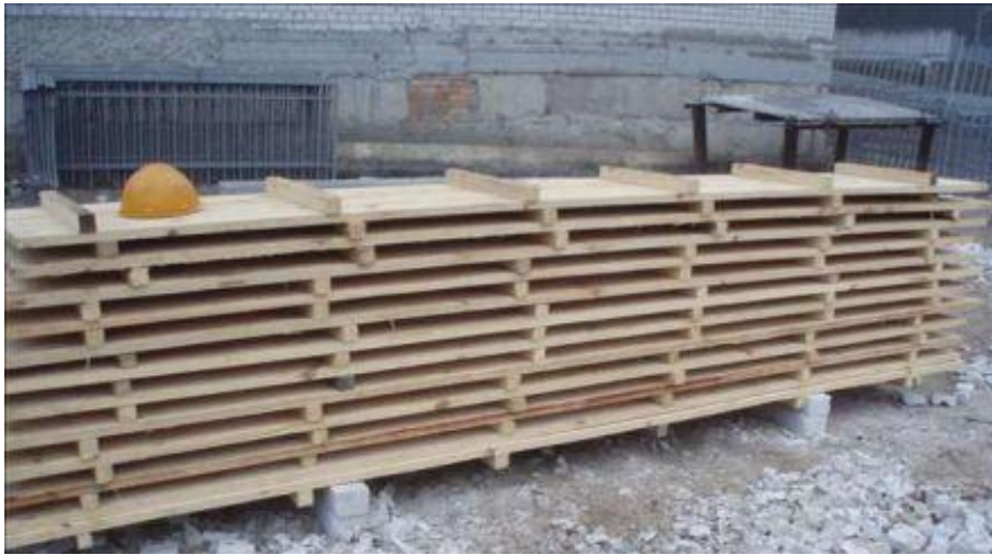
Рисунок 3.15- Щити розбірно-переставної опалубки
