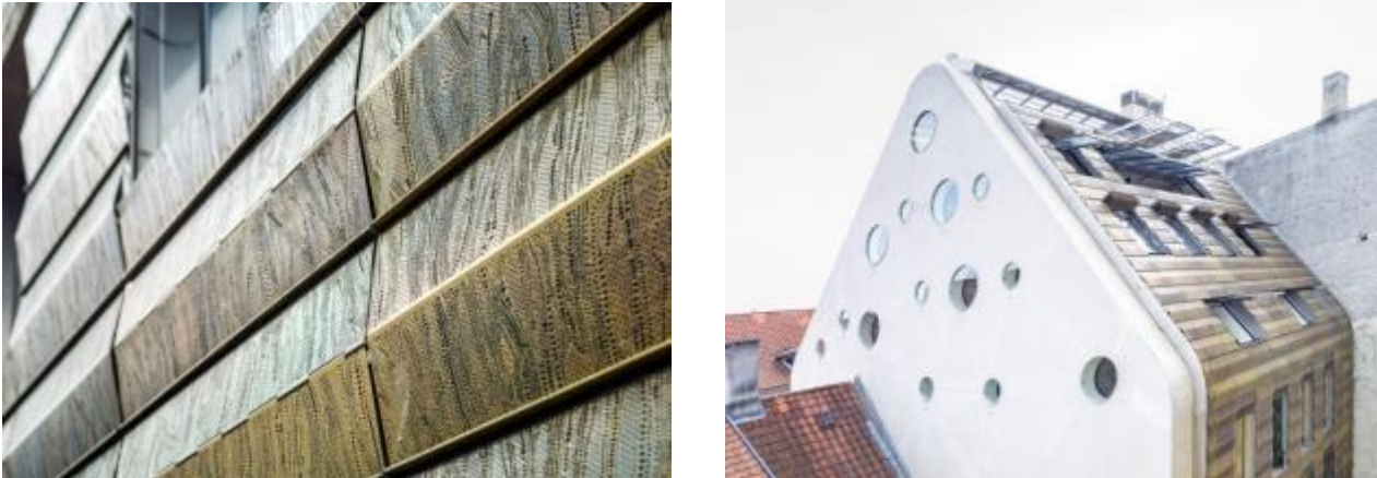
Рис. 4.2. (Продовження) Офіс компанії Тролбедс, ВВР Architecter, Копенгаген, 2013
