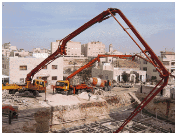
Рисунок 3.19 - Подача бетону в блоки бетонування
