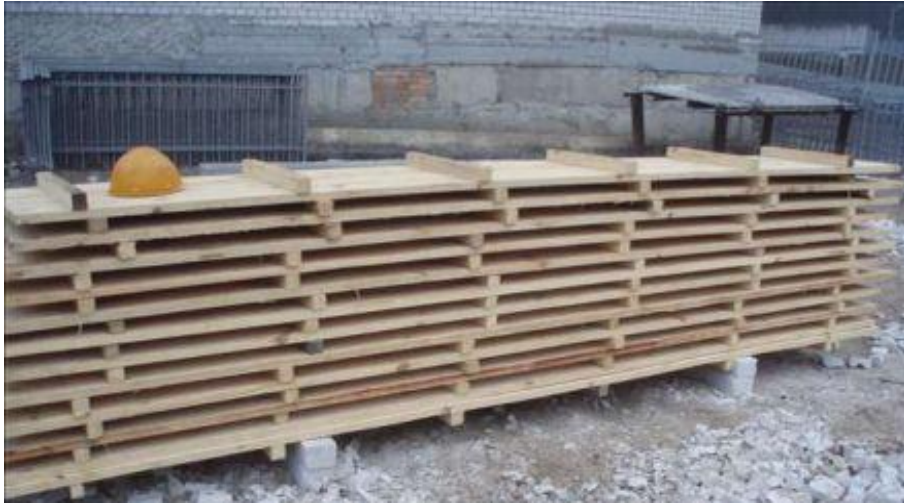
Рисунок 3.15- Щити розбірно-переставної опалубки
