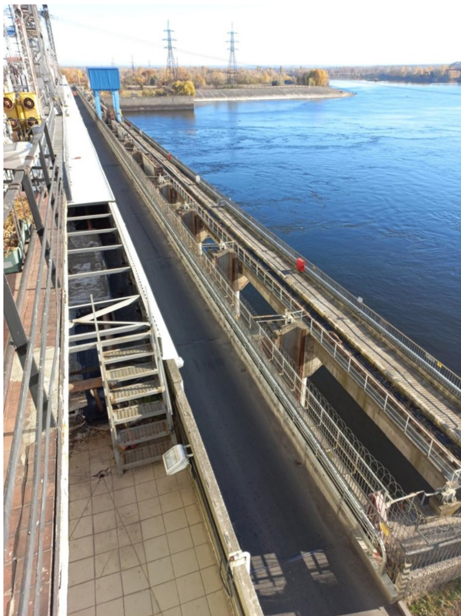
Рис. 2. Загальний вигляд автопроїзду по спорудам Канівської ГЕС
