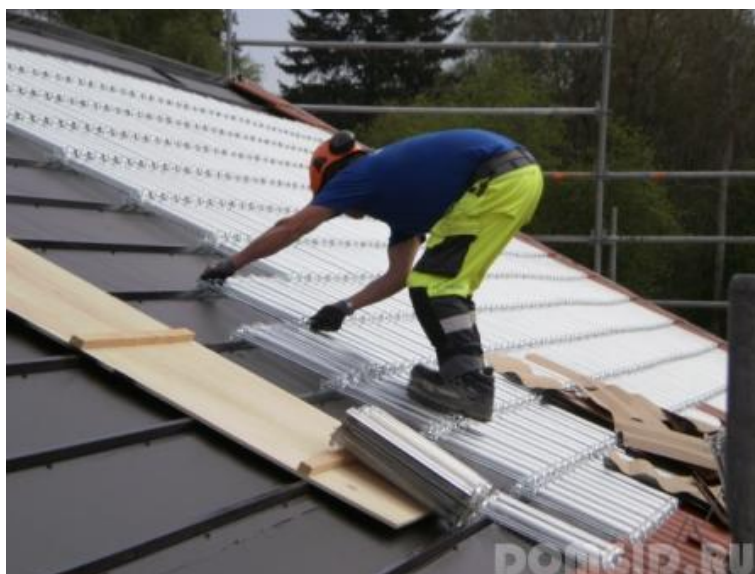
Рис. 3. Технологія влаштування скляної черепиці
