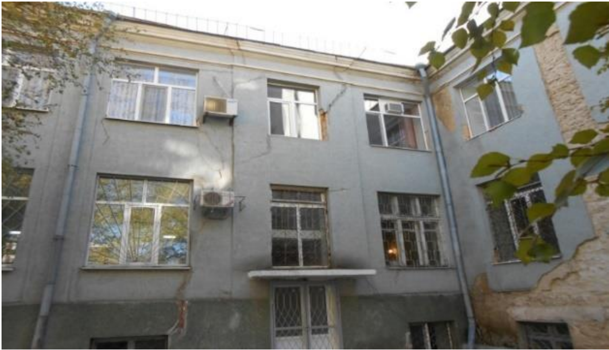
Фото 1. Руїнування міжвіконних простінків, похилі тріщини та обсипання штукатурки в фасадній частині будівлі
