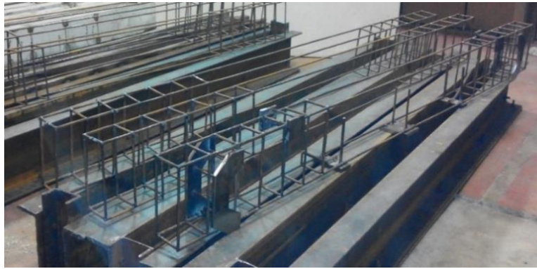
Рис. 1. Загальний вигляд арматурних карасів із закладними деталями
