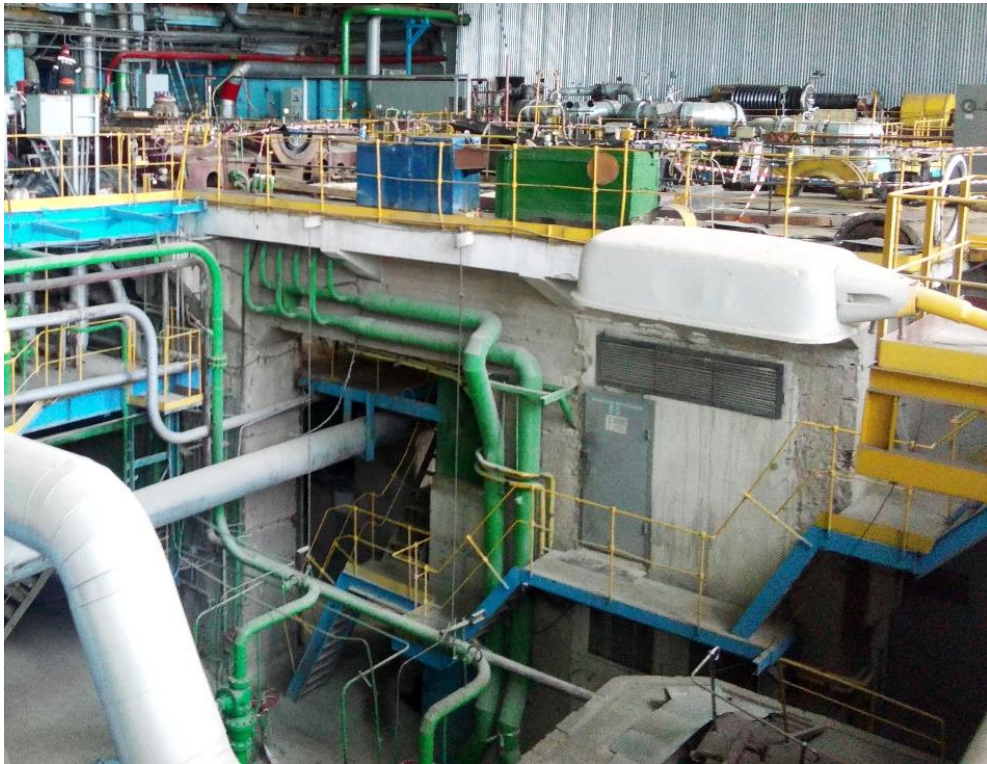
Рис. 2. Загальний вигляд фундаменту турбоагрегату
