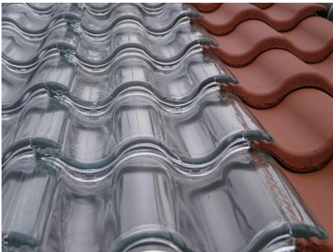
Рис. 4. Частина даху з різними видами черепиці
