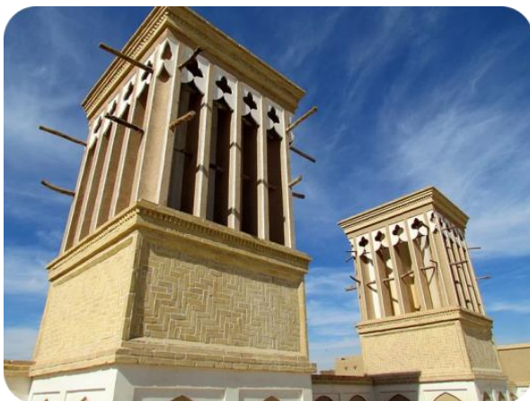
Фото 5. Вітрові вежі Бадгіри - традиційні прийоми охолодження та вентиляції
