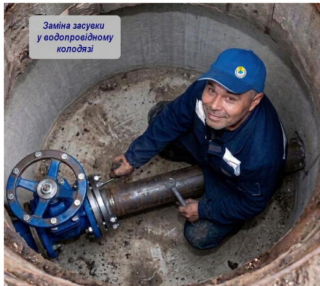
Рис. 5. Заміна засувки у водопровідному колодязі
