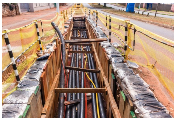
Рис. 1. Етап інженерної підготовки: перенесення комунікацій у підземні кабельні канали
