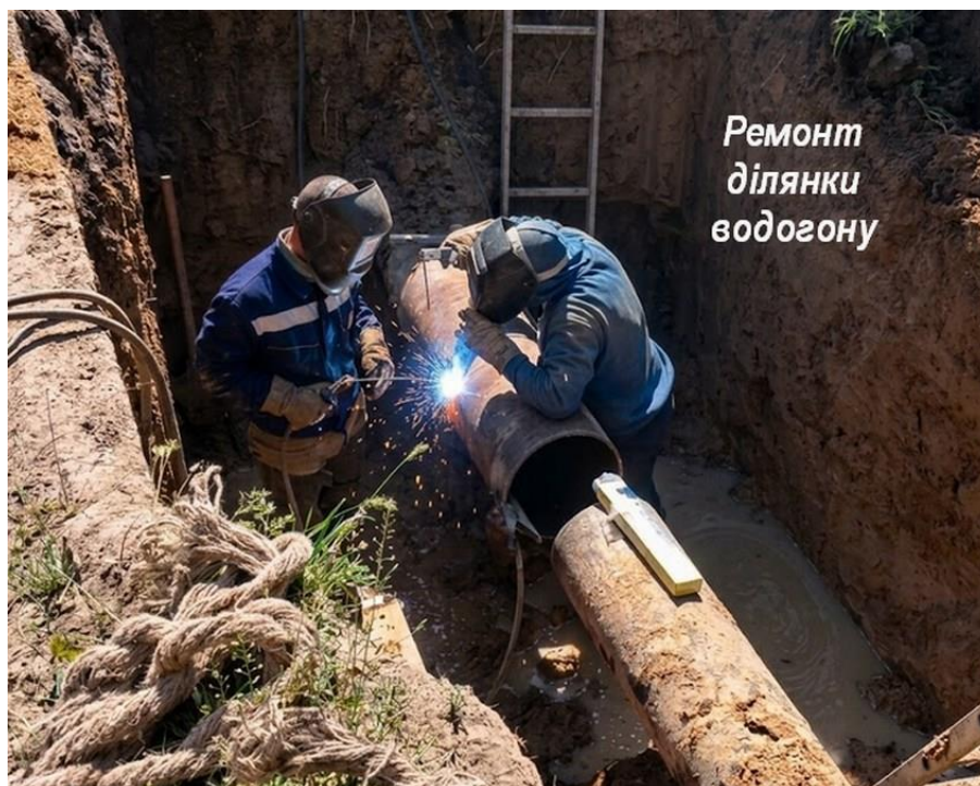
Рис. 3. Ремонт ділянки водогону
