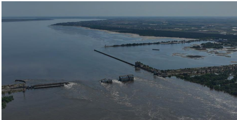
Рисунок 1 – Зона руйнування Каховської ГЕС та формування потоку прориву в нижній б'єф
