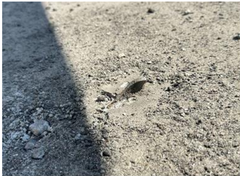
Рис. 3. Сталевий уламок від ракетного удару в тілі монолітної плити
