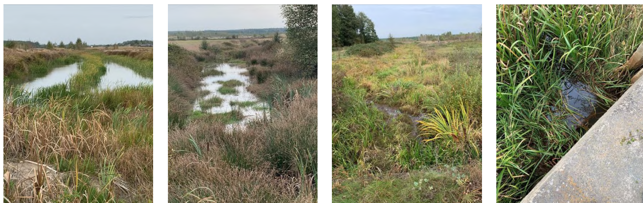
Рисунок 3 – Магістральний канал та трубчатий переїзд ТП 150 (пікет 148+70)
