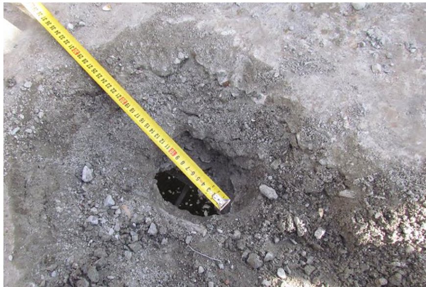
Рис. 4. Вхідний отвір у плитній частині таврових залізобетонних балок прогонової будови моста
