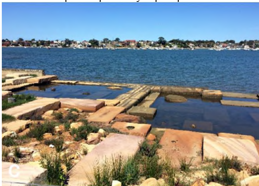
Рис. 1. Захист узбережжя від повеней – екологічно чиста морська стіна в парку Карс Буш, Новий Південний Уельс, Австралія
