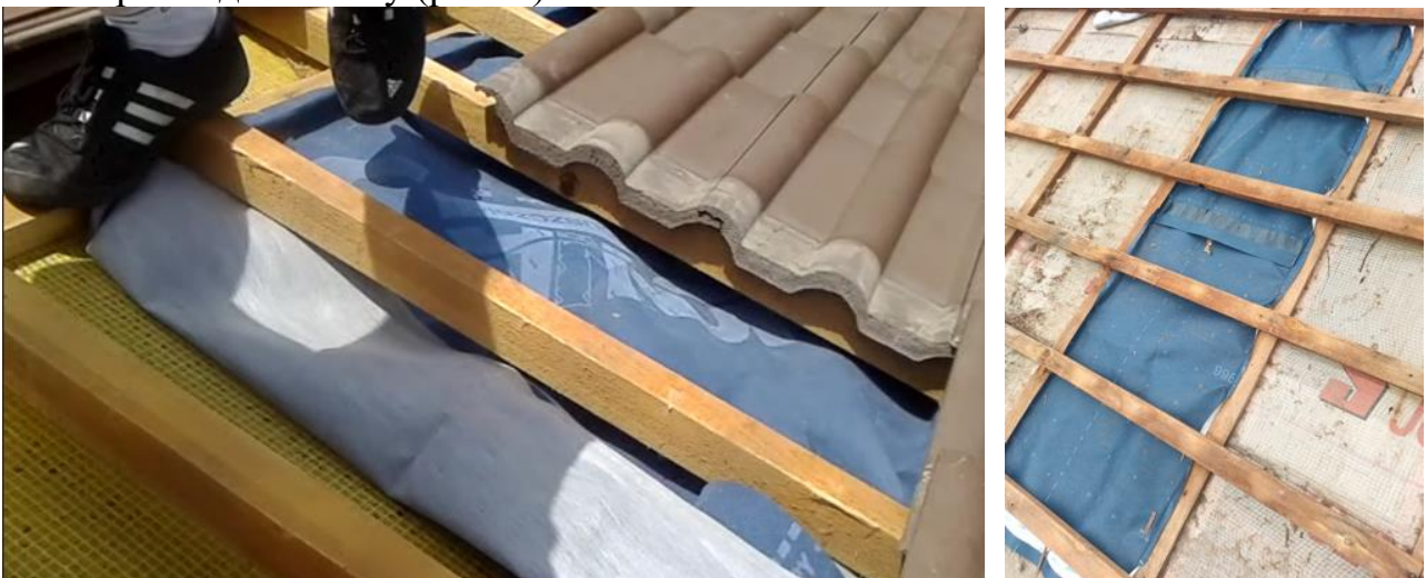
Рис. 3. Приклади монтажу мембрани
