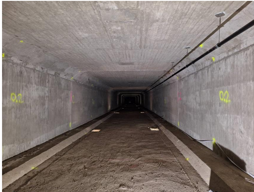
Рис. 4. Вигляд всередині коробчастої балки
