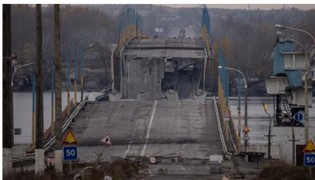
Рис. 6 Зруйнований міст через р. Дніпро
