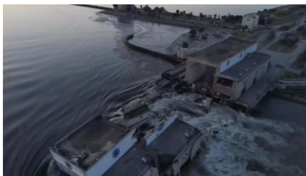
Рис. 5. Зруйнована Каховська ГЕС
