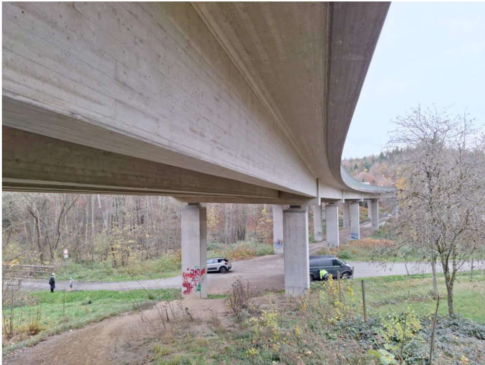
Рис. 1. Загальний вигляд залізобетонного моста
