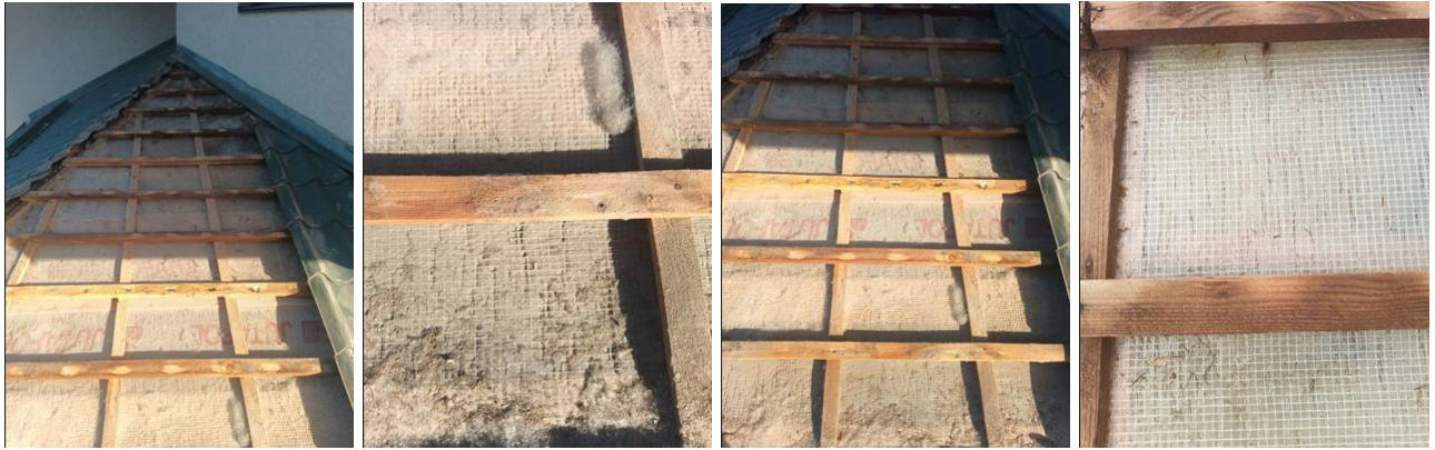
Рис. 2. Руйнування найкращого плівкового гідробар'єру за якістю бренду «Jutta»
