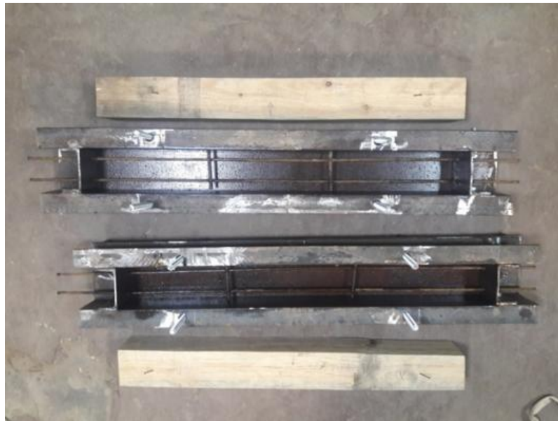
Рис. 6. Опалубка для виготовлення пресованого залізобетонного елемента
