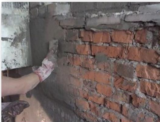
Рис. 4. Нанесення проникаючої цементної гідроізоляції на мурування з керамічної цегли
