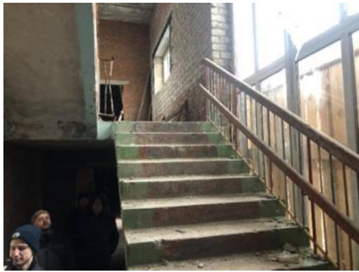
Фото 4. Обладнання сходів поручнями для дітей та дорослих
