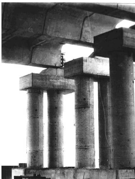
Рис. 5. Експлуатація обтиснених за методом «на суміш» стояків опор мостового переходу через р. Дніпро в м. Кам'янськ
