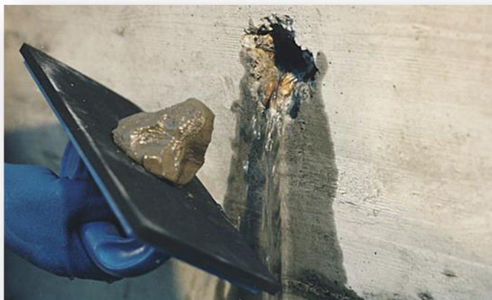
Рис. 3. Закладення отвору пломбовою гідроізоляцією на основі цементу
