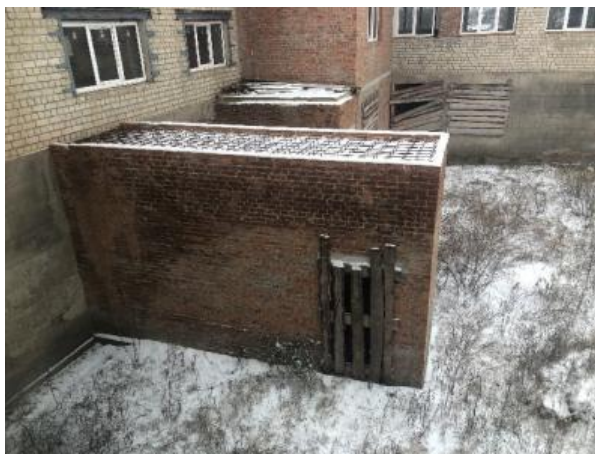
Фото 6. Влаштування додаткового виходу назовні з підвалу
