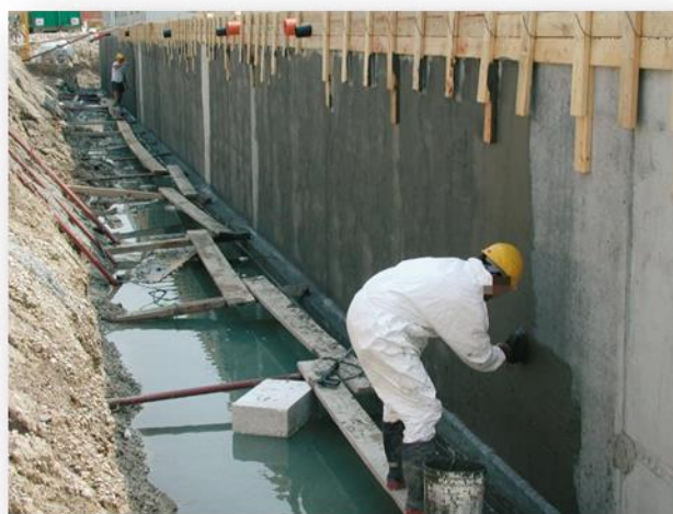
Рис. 1. Нанесення жорсткої цементної гідроізоляції на залізобетонний фундамент
