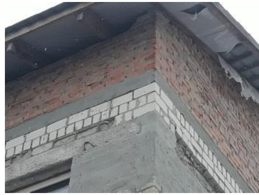
Фото 5. Збільшення висоти приміщень за рахунок монолітного з/б поясу та цегляної кладки (в момент реконструкції 2020-2021 рр).
