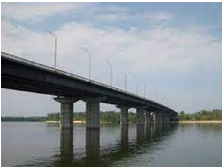
Рис. 4. Загальний вигляд мостового переходу через р. Дніпро в м. Кам'янськ
