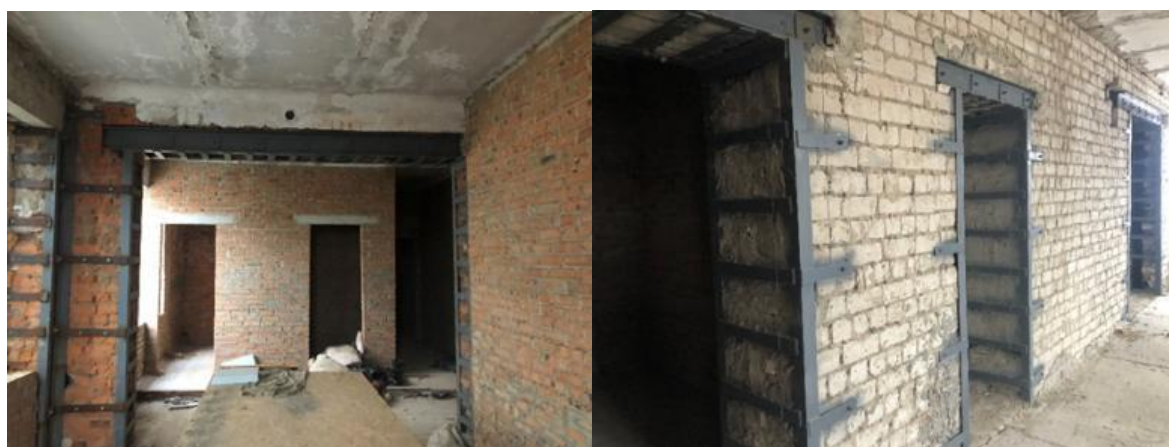
Фото 3. Влаштування нових дверних прорізів та розширення існуючих з підсиленням
