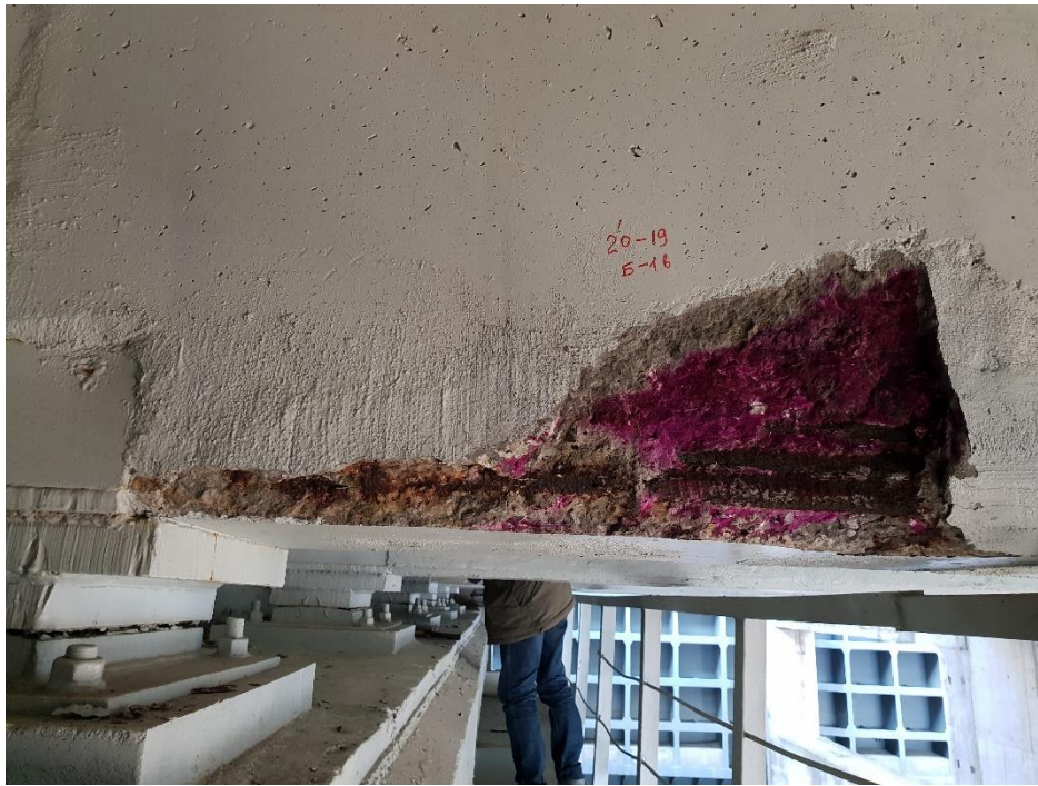
Рис. 4. Карбонізація, корозія поздовжньої арматури ребра балки
