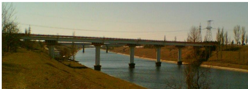
Рис. 1. Ділянки досліджень: а) арочний міст с. Бургунка Бериславського району; б) Цюрупінський міст м. Олешки Олешківського району; в) вантовий міст с. Белоусово Великоолександрівського району; г) Панкратівський міст м. Херсон; д) міст через канал с. Лукьянівка Каховського району
