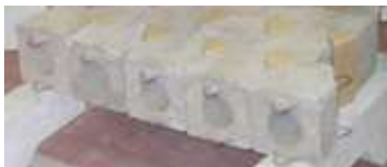
Рис.1. Фрагмент перекриття з дрібноштучних елементів
