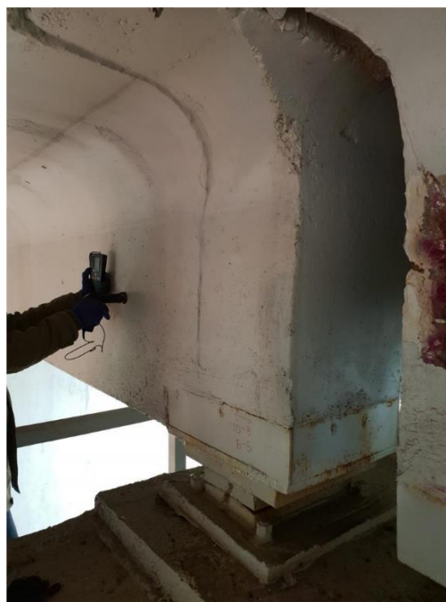
Рис. 1. Визначення міцності бетону балки Б-5 на опорі 8 неруйнівним методом за допомогою електронного приладу BetonProCONDROL
