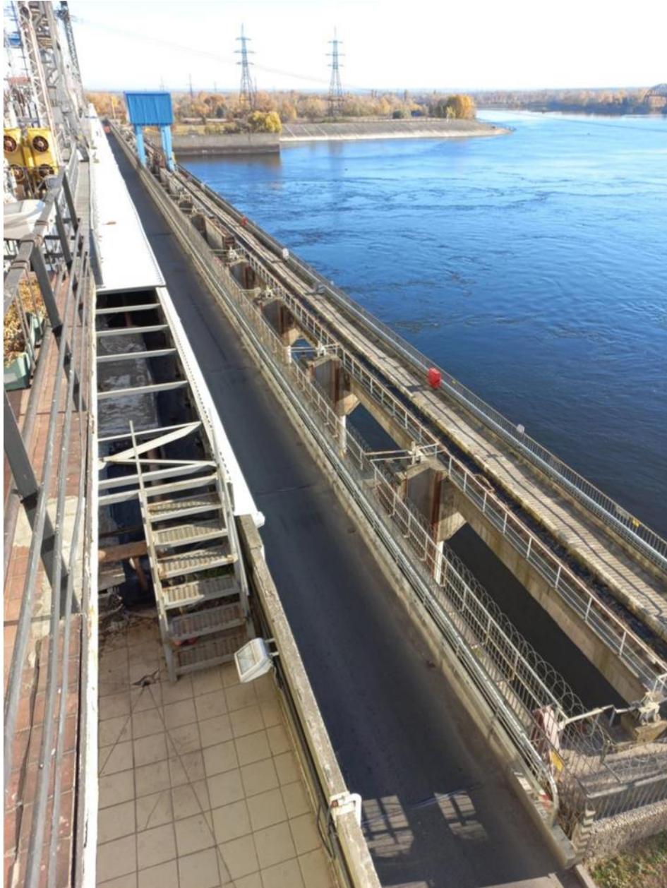
Рис. 2. Загальний вигляд автопроїзду по спорудам Канівської ГЕС
