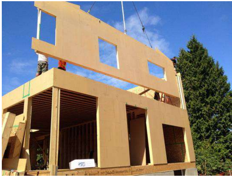
Рис.2. Монтаж будинку з CLT-панелей
