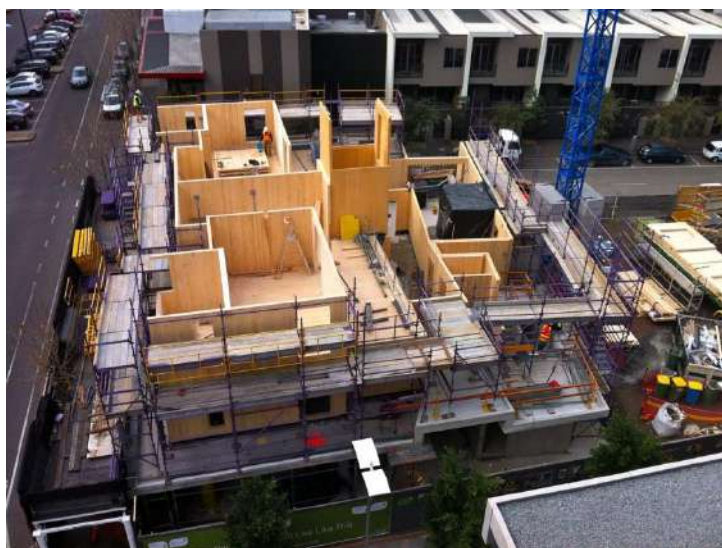
Рис.3. Монтаж двосекційного багатоповерхового будинку
