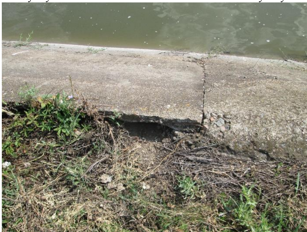
Рис. 3. Руйнування заплечиків
