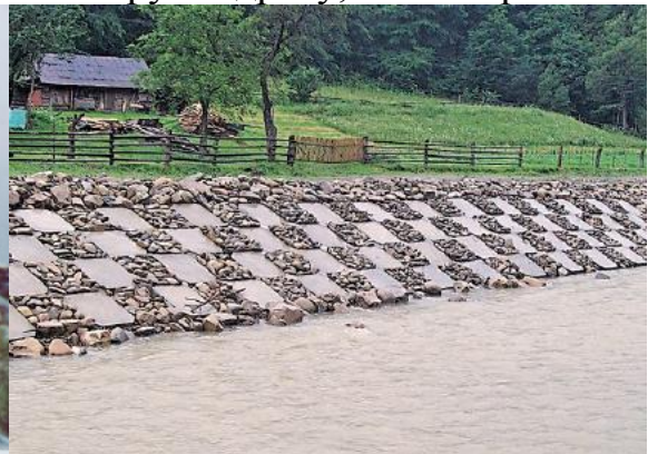
Рис. 6. Гнучке покриття із залізобетонних плит
