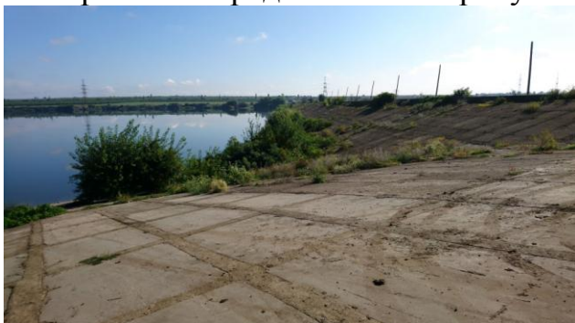
Рис. 1. Загальний вигляд дамби
