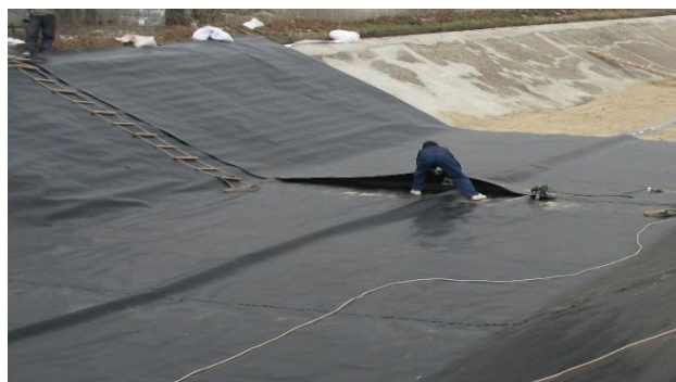
Рис. 4. Облаштування протифільтраційного покриття
