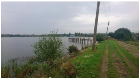
Рис. 1. Загальний вигляд дамби водосховища
