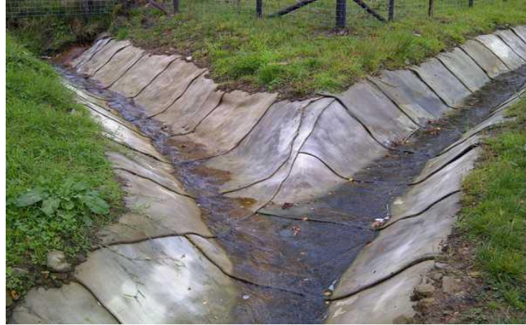
Рис.7. Використання Concrete Canvas для облицювання каналу
