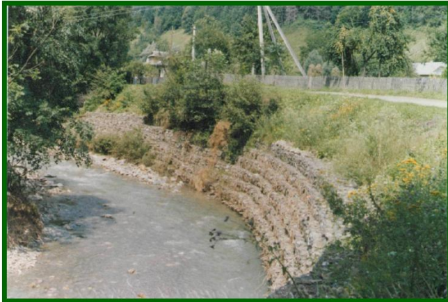
Рис. 3. Кріплення габіонами р. Рожень Великий (ліва притока р. Черемош)
