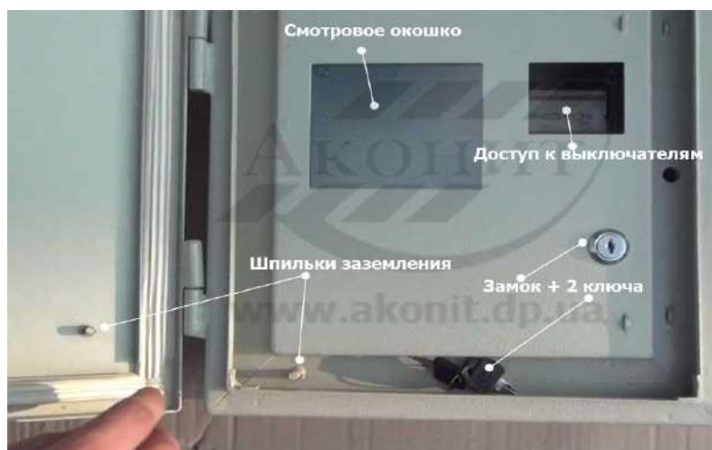
Рисунок 4 – Вологозахисний вуличний електрощит
