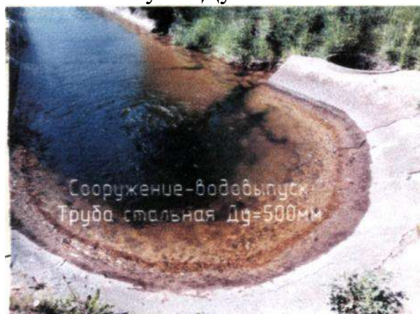
Рисунок 4 – Споруда – водовипуск, труба сталевая Ду=500 мм
