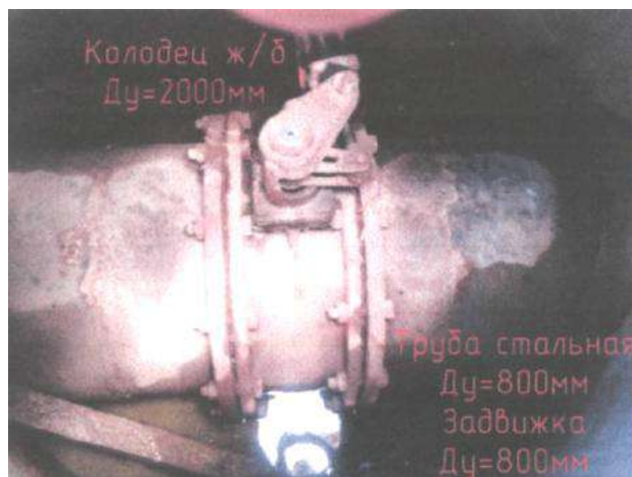
Рисунок 3 – Колодязь з/б Ду=2000 мм, труба сталевая Ду=800мм, засувка Ду=800мм
