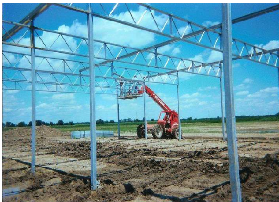
Рис. 2 - Монтаж елементів покриття
