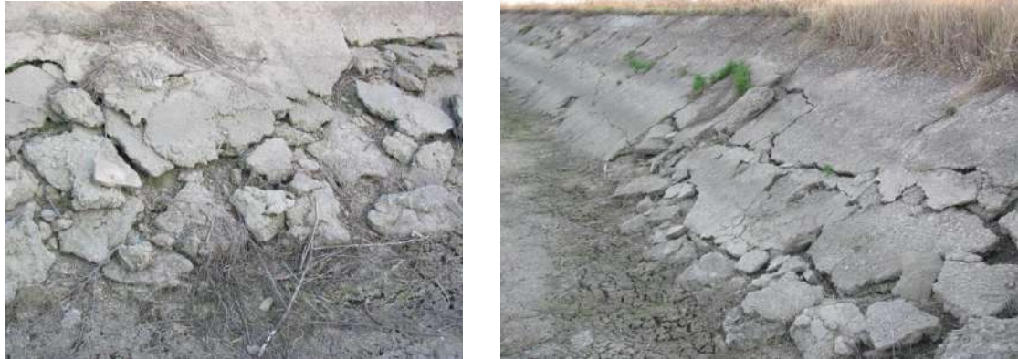
Рис. 1.2 – Стан облицювання каналу Р-1 ПК40-ПК41
