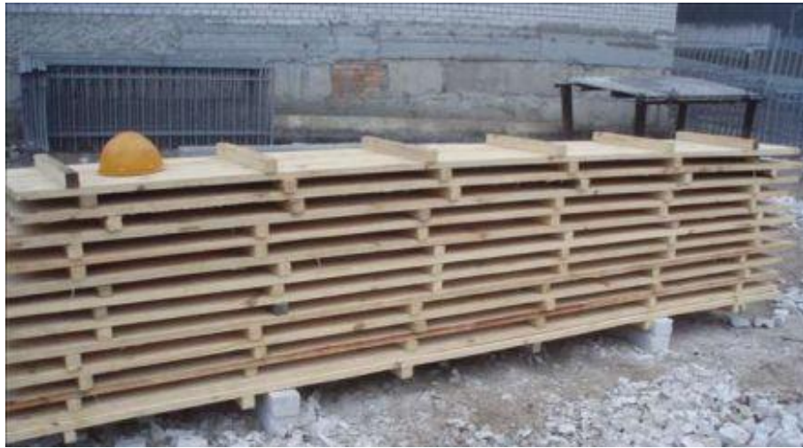
Рисунок 3.15- Щити розбірно-переставної опалубки
